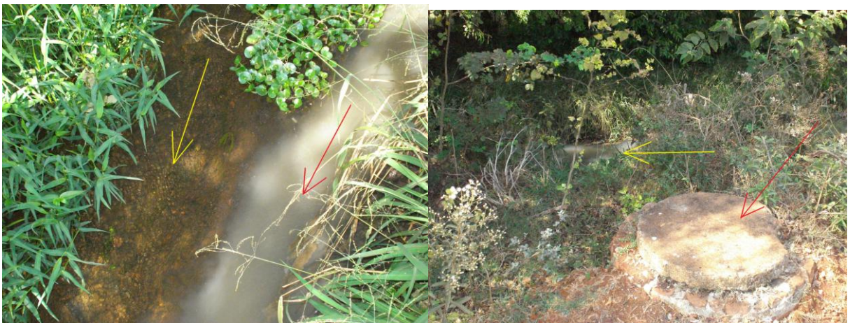
Figura 07. Imagem mostrando curso de água com possível vazamento em duto de esgoto.
